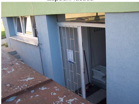
Stávající kovový vstup do suterénu
